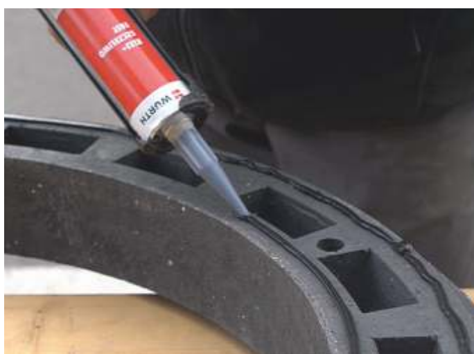
Aplikacja masy polimerowej uszczelniająco-spajającej na powierzchni dolnej pierścienia wyrównawczego
