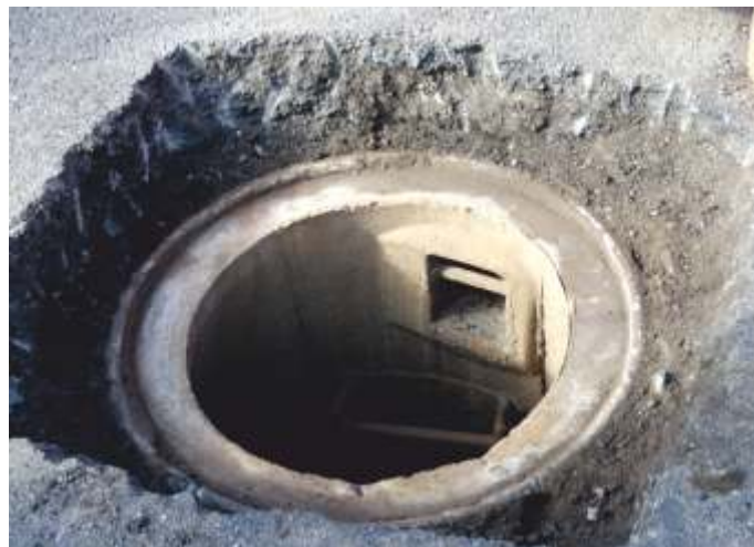
❶ Zwężka studzienki betonowej DN 625 w dobrym stanie technicznym spełniająca warunki do montażu zwieńczenia przypowierzchniowego. Drobne ubytki i nierówności powierzchni do wyrównania warstwą wyrównawczą.
