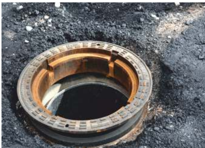
Adapter/pierścień prowadzący TXS/635/80 wspierający wjazd samopoziomujący EASY LOCK podczas montażu.
