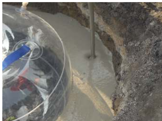
Szalunek Pu-TS 625 osadzony w otworze włazowym studzienki umożliwia wylanie warstwy wyrównawczej.
