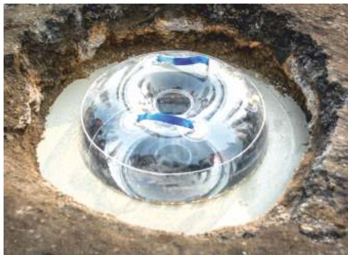
❶ Aplikacja szybkowiążącej elastycznej masy wyrównawczo naprawczej na bazie cementów. Bardzo szybki czas wiązania, możliwy natychmiastowy montaż elementów zwieńczenia przypowierzchniowego.
