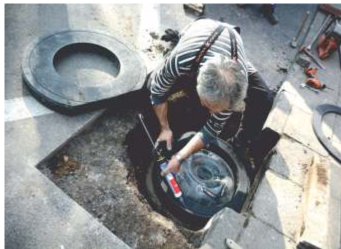
Aplikacja mas polimerowych między elementami rehabilitowanego zwieńczenia przypowierzchniowego wpustu ulicznego.
