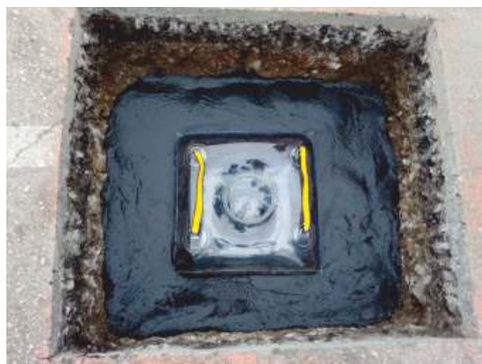
Szalunek pneumatyczny 500x500 zainstalowany w studzience o przekroju kwadratowym.
