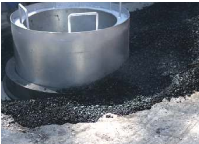
Przygotowanie konstrukcji wspierającej wąż samopoziomujący z elementów Systemu TVR T i gorącej masy asfaltowej. Temperatura masy asfaltowej (170°C) nie wpływa na parametry pierścieni wyrównawczych i prowadzących w trakcie wbudowywania.
