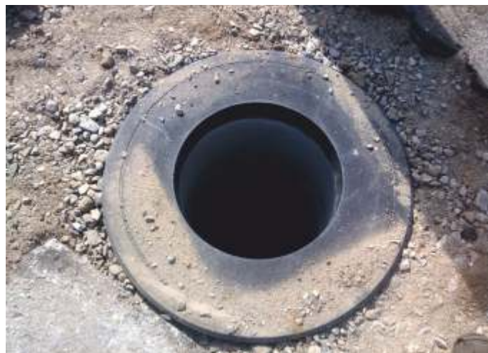
Adapter TX/765/410 przygotowany pod montaż wpustu ulicznego 400x600, osadzony na betonowej studzience deszczowej DN 450.
