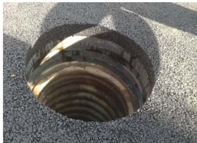
Zwieńczenie przypowierzchniowe studzienki Tegra 600 wykonane z elementów Systemu TVR T (pierścienie wyrównawcze T1/700/50, pierścień prowadzący TXS/700/80,) przygotowane do osadzenia włazu samopoziomującego. Jelenia Góra-S-3.
