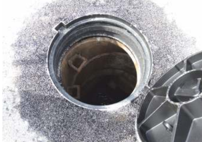
Regulacja wysokościowa włązu wykonana na elementach Systemu TVR T
