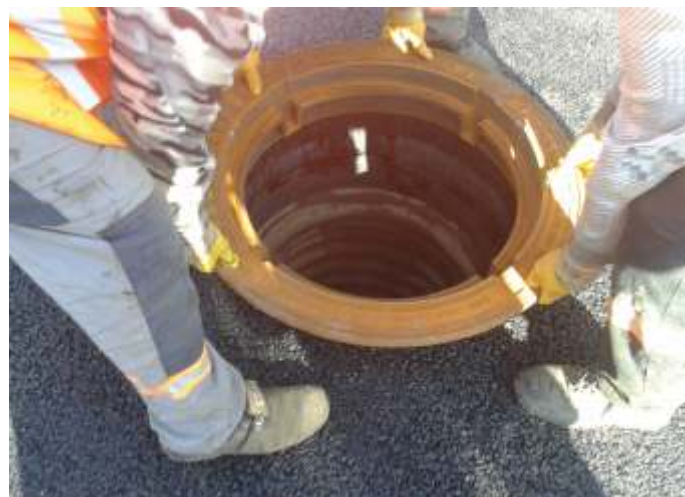
Właz samopoziomujący instalowany w zagęszczonej nawierzchni asfaltowej z wykorzystaniem elementów systemu TVR T do budowy zwieńczenia przypowierzchniowego studzienki tworzywowej Tegra 600. Jelenia Góra-S-3.
