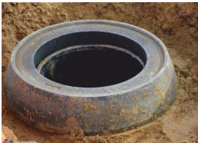
Stożek odciążający T3/615 zabezpieczający rurę trzonową studzienki DN600.
