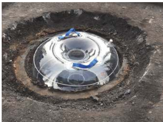
Przed przystąpieniem do prac rozbiórkowych zwieńczenia szalunek pneumatyczny może służyć jako zabezpieczenie przed zanieczyszczeniem.
