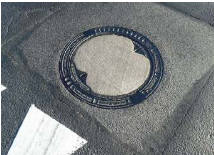
Zwieńczenie przypowierzchniowe wykonane za pomocą pierścieni wyrównawczych T1/700 oraz adaptera TXS/710/80 umożliwiające posadowienie włazu samopoziomującego. Legnica droga S-3 krzyżowy najazd na właz, obciążenie ruchem pasa Kr 4. 6lat eksploatacji.
