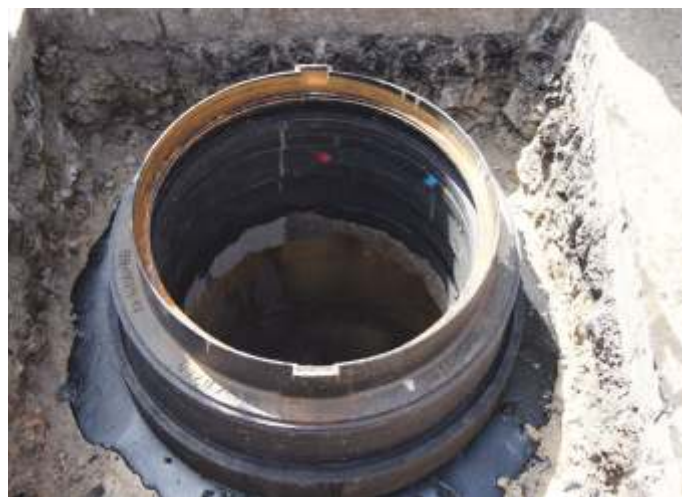
Zwieńczenie studzienki wjazdowej wykonane w oparciu o pierścienie wyrównawcze T1R/625 i T1/600 wraz z pierścieniami klinowymi T1K/600/9/22. Wysokość regulacji 24cm. Warstwa wyrównawczo-naprawcza wykonana w oparciu o żywiczną masę zalewową.
