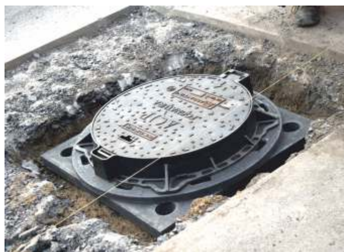
Rehabilitacja zwieńczenia studzienki wykonana w oparciu o elementy regulacyjne Systemu TVR T
