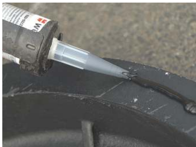
Aplikacja masy polimerowej uszczelniająco-spajającej na powierzchni dolnej stopy nośnej wjazdu kanałowego
