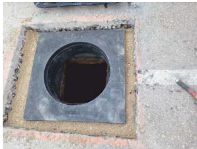
Płyta fundamentowa T04/850/620/50 posadowiona na pierścieniach wyrównawczych T1/600 i podbudowie nawierzchni, przygotowana do montażu wjazdu o stopie kwadratowej 850x850.
