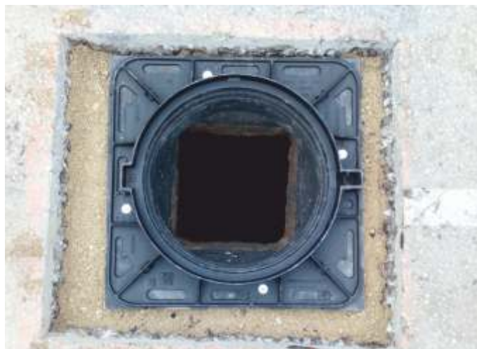
Właz z żeliwa sferoidalnego o kwadratowej stopie korpusu 850x850mm osadzony na płycie fundamentowej T04/850/620/50 zapewniającej pełne podparcie włazu. Właz zakotwiony śrubami do płyty. Regulacja wysokościowa wykonana za pomocą pierścieni wyrównawczych T1/600.
