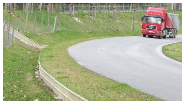
Instalacja w poboczu drogi
