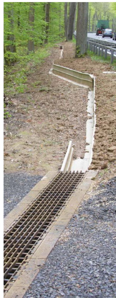
Montaż stoprynnny w ścieżce żwirowej
