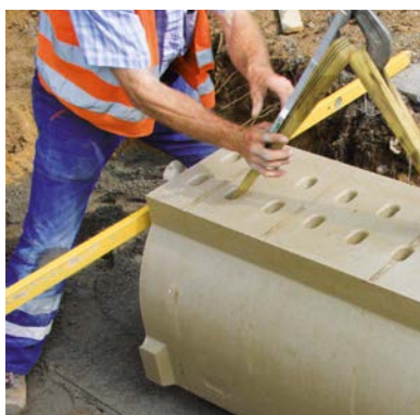
Układanie tunelu ACO PRO KT 500
