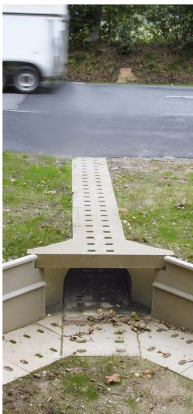
Alternatywa - tunel podpowierzchniowy
