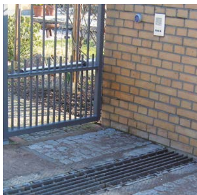
Rozwiązanie specjalne ze stoprynną pod ścianą
