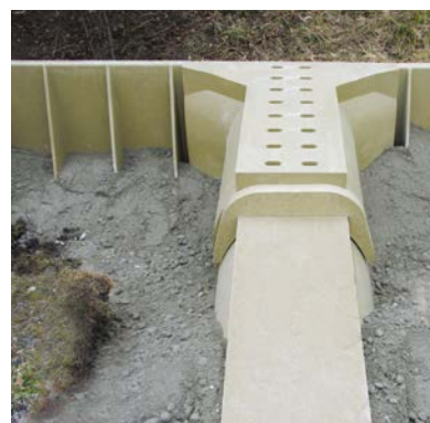
Montaż paneli wejściowych i ścianek naprowadzających
