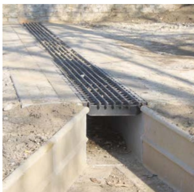
Montaż z krawędziami
